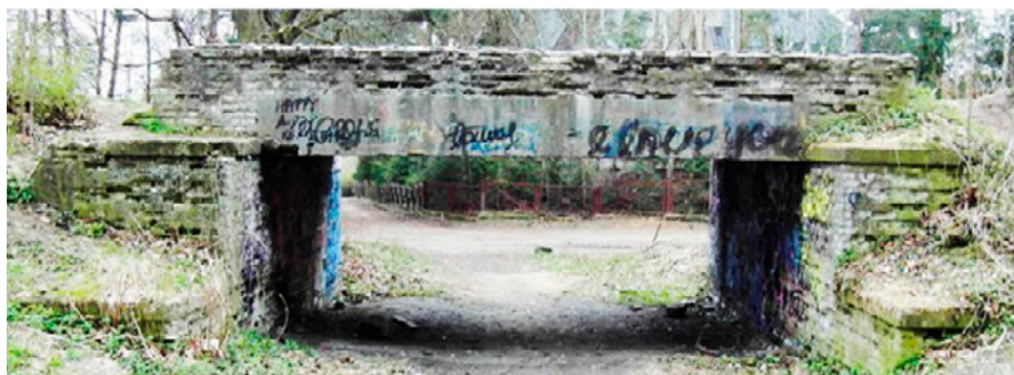
Fot. 3. Niewielki wiadukt przy Kościele pw. Zmartwychwstania Pańskiego od wspomnianej prawej strony ze schodkowaniem pod rozbudowę na drugi tor.
