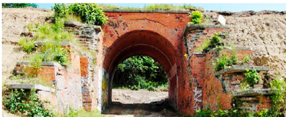
Fot. 5. Wiadukt w okolicach zakończenia ul. Ogrodowej, od prawej strony z widocznym schodkowaniem.
