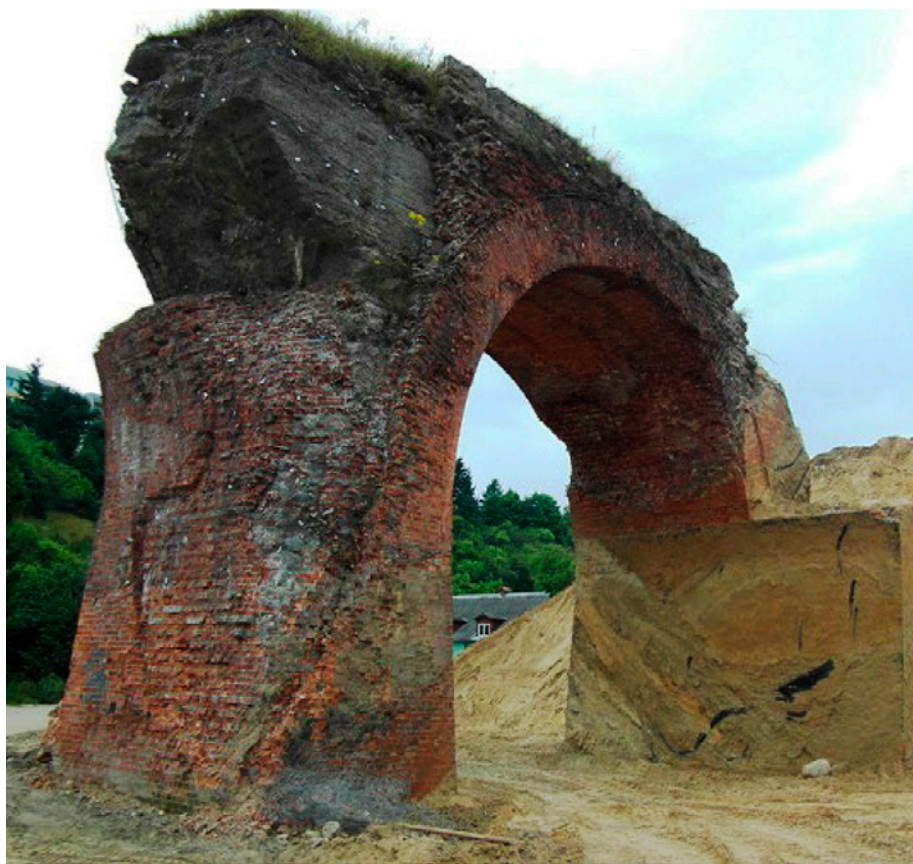
Fot. 2. Fragment wiaduktu nad ul. Dolne Migowo.
