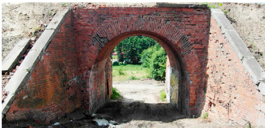
Fot. 6. Ten sam wiadukt, ale od drugiej strony.
