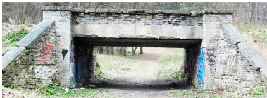
Fot. 4. Zdjęcie tego samego wiaduktu z drugiej strony.
