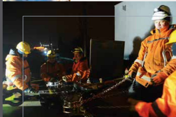
Ważący 450 ton stalowy wiadukt PKM był ręcznie obracany przez kilkunastu robotników.
