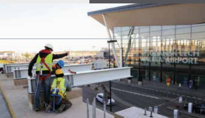
Montaż konstrukcji peronów na przystanku PKM Gdańsk-Port Lotniczy.
