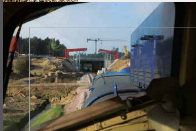
Przystanek PKM Gdańsk-Matarnia widziany z kabiny lokomotywy SM42-872 „Tamarą”.
