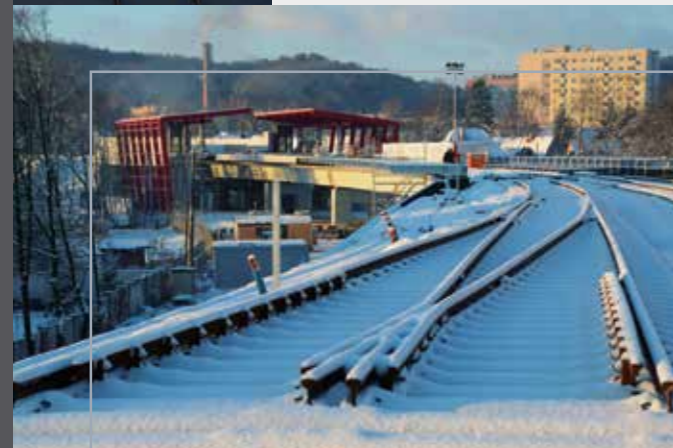
Nowe torowisko na nasypie w okolicach przystanku PKM Gdańsk-Strzyża.
