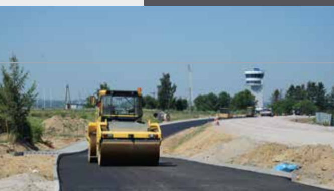
Nowa ul. Szybowcowa w Gdańsku, biegnąca wzdłuż nasypu PKM.
