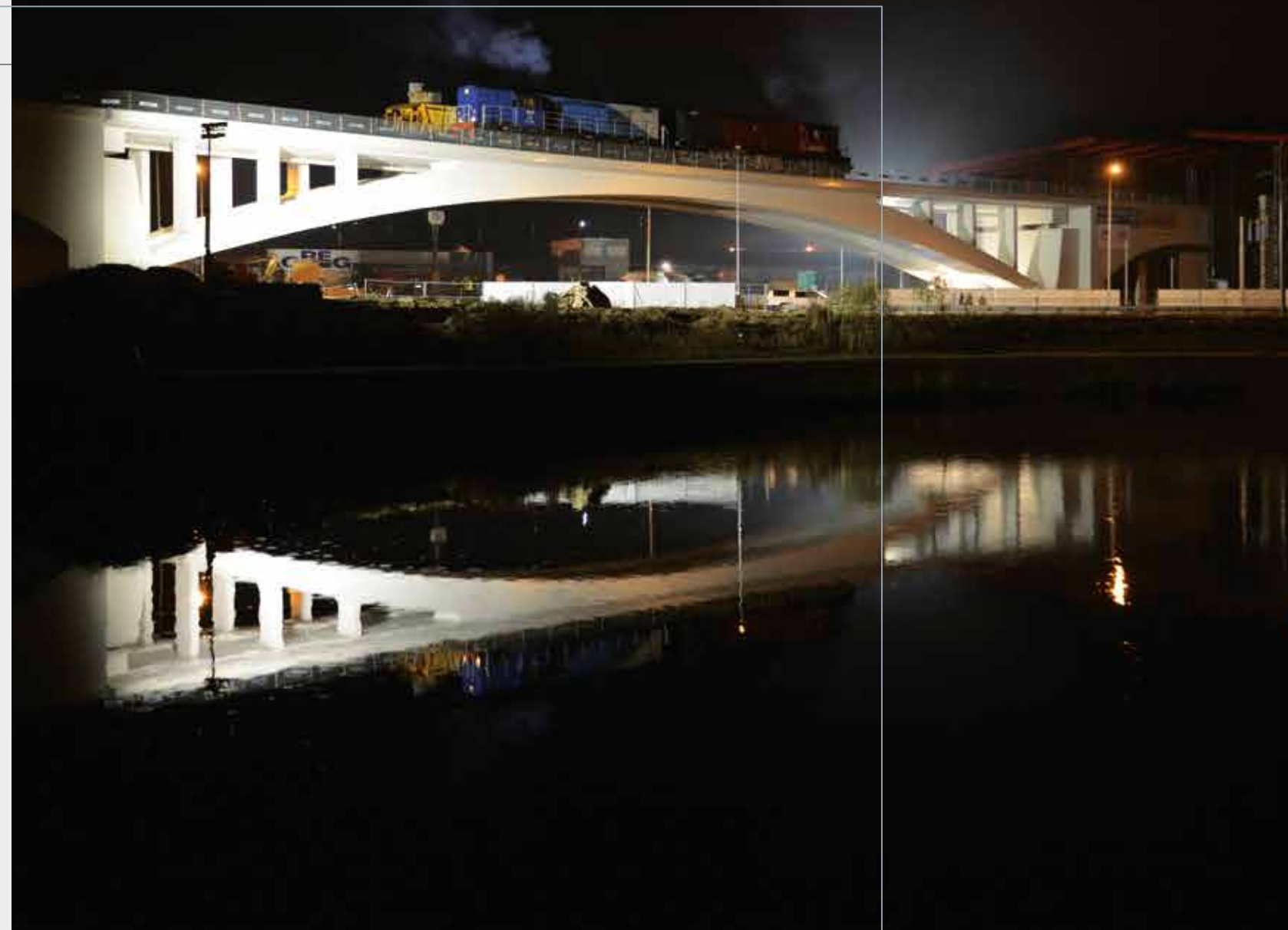
Nocne próby obciążeniowe wiaduktu kolejowego nad ul. Słowackiego, z udziałem ważących łącznie ponad 500 ton pojazdów szynowych.
