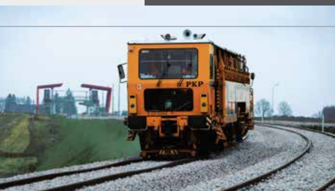
Podbijarka torowa pracująca w okolicach przystanku Gdańsk-Rębiechowo.
