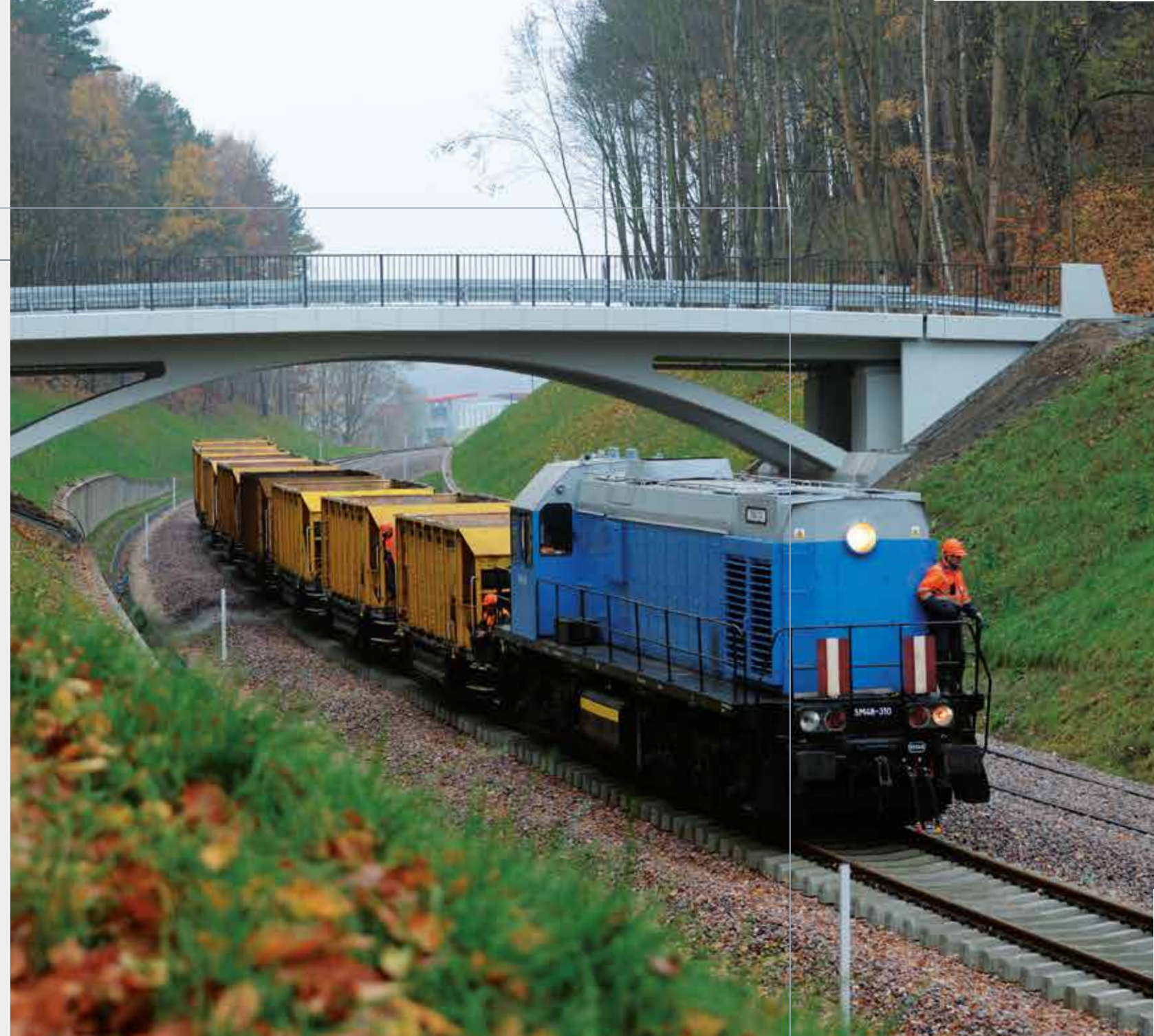
Przejazd lokomotywy ciągnącej wagony z tłuczniem pod nowym Mostkiem Weisera. W tle przystanek PKM Gdańsk-Niedźwiednik.
