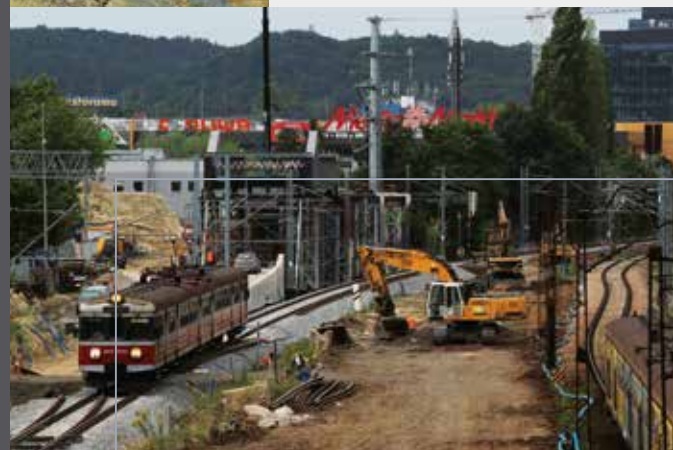
Miejsce budowy wiaduktu stalowego WK 2, na styku linii PKM i E 65.
