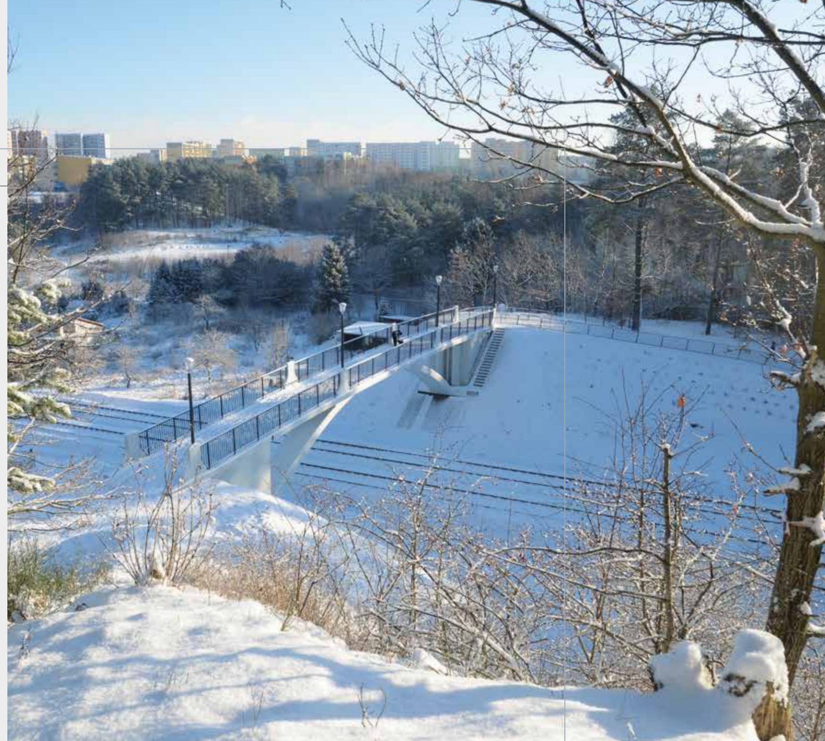
Malowniczo położona kładka dla pieszych na Dolnym Migowie, oznaczona symbolem KL 19, pod koniec 2014 r. otrzymała już oficjalną zgodę na użytkowanie.
