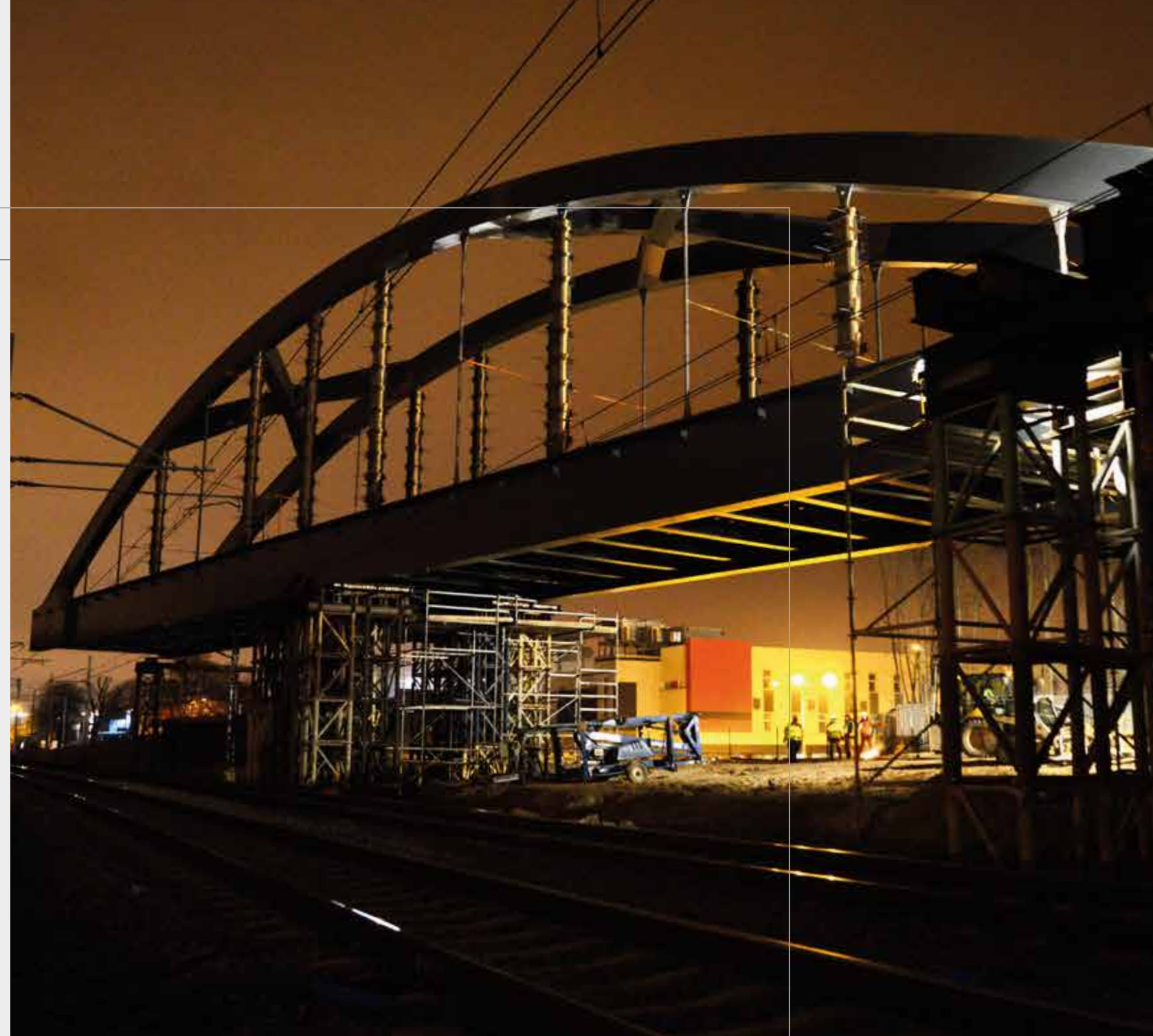
Operacja nasuwania wiaduktu WK 2 na docelowe miejsce rozpoczęła się po północy 2 grudnia a zakończyła się nocą z 10 na 11 grudnia 2014 r.
