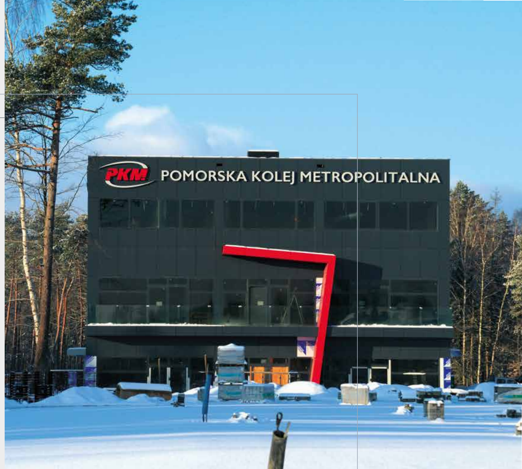
Budynek Lokalnego Centrum Sterowania PKM na gdańskiej Matarni – to z tego miejsca odbywać się będzie kierowanie ruchem na nowej linii kolejowej.
