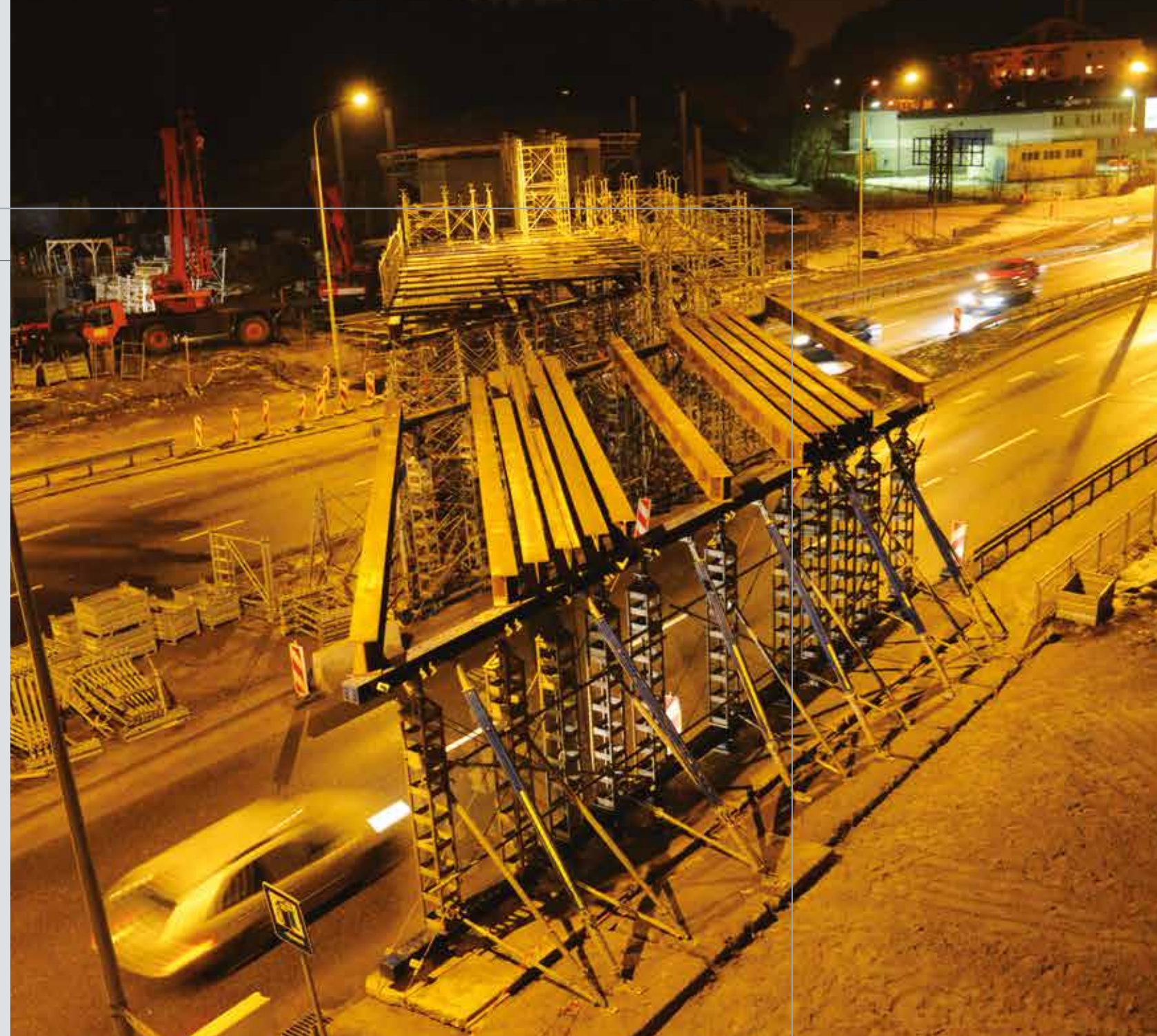
Tzw. bramownice, na których oparte zostały rusztowania budowanego nad ul. Słowackiego wiaduktu, montowane były nocą, aby prace nie paraliżowały ruchu na głównej arterii komunikacyjnej Gdańska.
