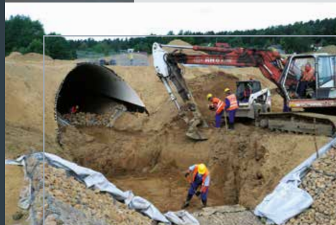
Budowa przejścia dla zwierząt z przepustem wodnym PZ 30 na gdańskiej Matarni.
