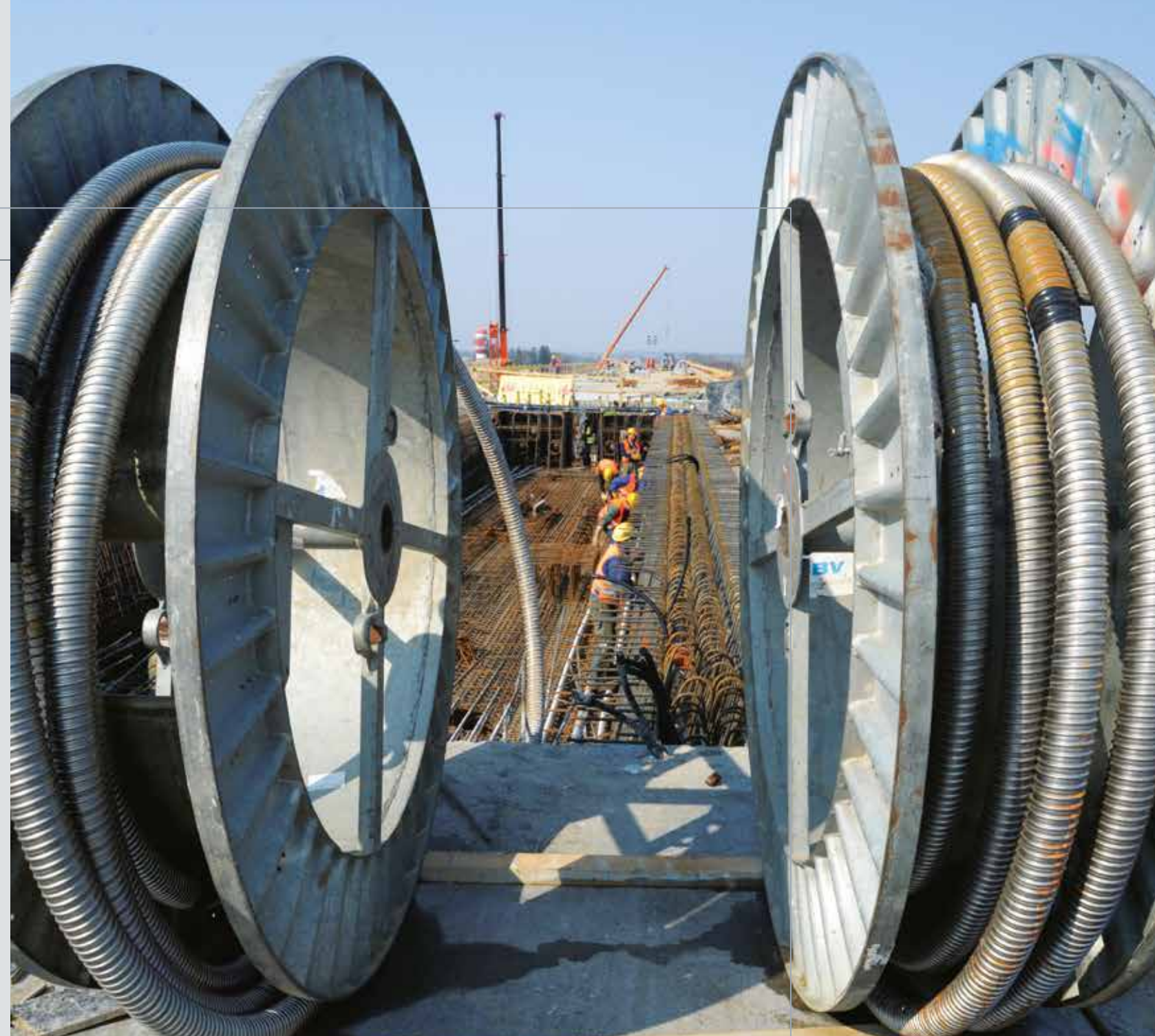
Stanowiącą największe wyzwanie inżynierskie 940-metrową, 25-przęsłową estakadę wzdłuż gdańskiego lotniska udało się wybudować w ciągu 13 miesięcy.
