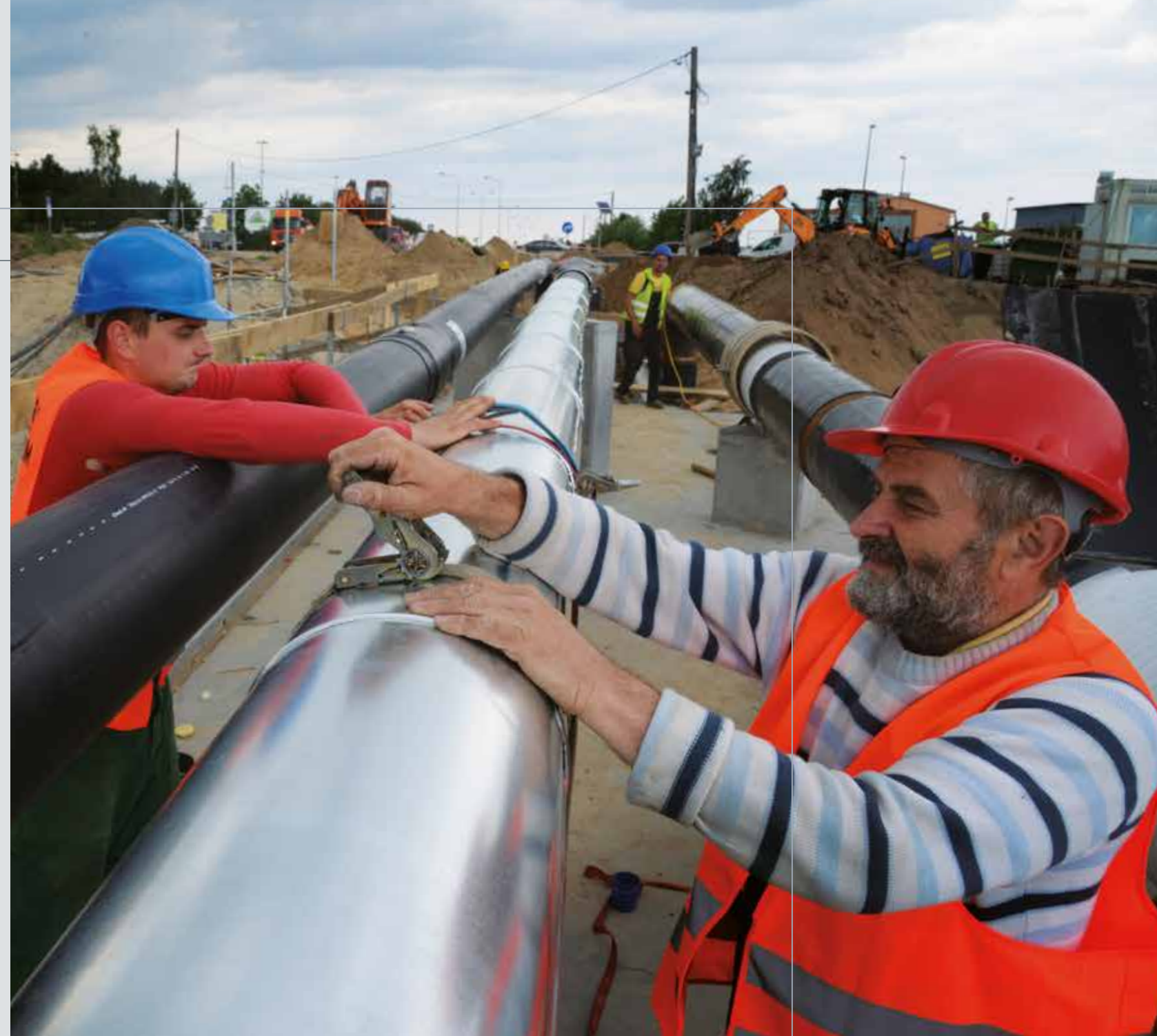
Kładkę technologiczną nad przystankiem PKM Gdańsk-Matarnia poprowadzone zostały m.in. nowe sieci: ciepłownicza i gazowa.
