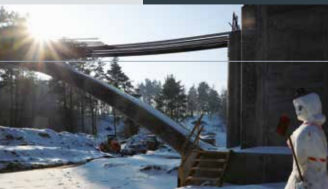
Zima na budowie też może być piękna... Na zdjęciu kładka dla pieszych KL 19 na Dolnym Migowie.
