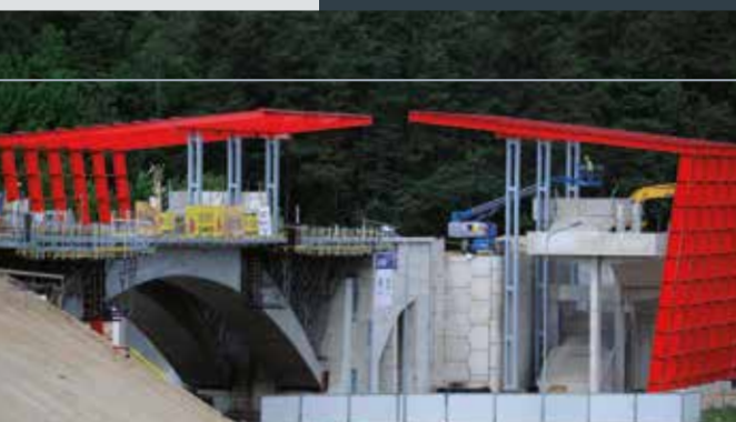
PKM Gdańsk-Nieźwiednik był drugim przystankiem, na którym zamontowana została konstrukcja czerwonej wiaty.
