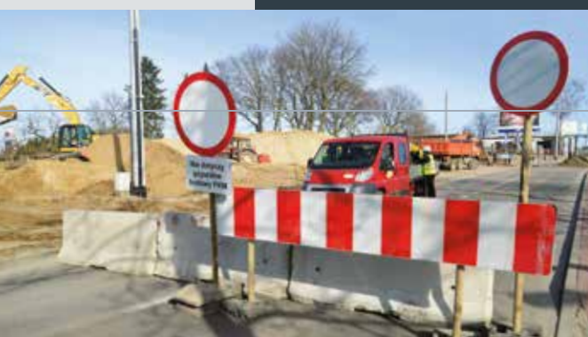
Zamknięty w związku z budową PKM odcinek starej ul. Słowackiego przy gdańskim lotnisku.
