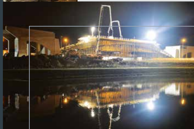
Wykonanie ustroju nośnego wiaduktu WK II było największym jednorazowym betonowaniem na budowie PKM.
