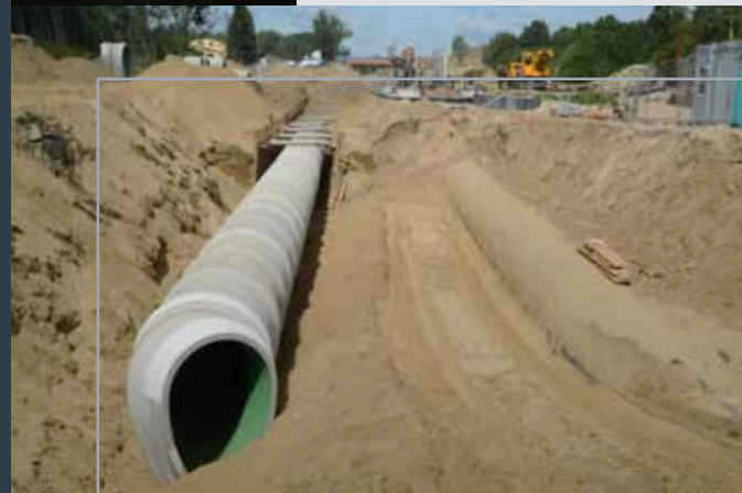
Kolektor jajowy na gdańskim Kiełpiku to największy odcinek kanalizacji sanitarnej przebudowywanej przez PKM.
