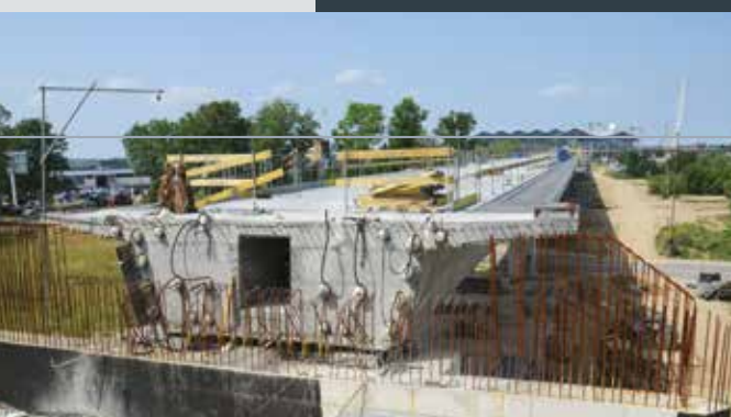
Ukończona już konstrukcyjnie estakada PKM przy gdańskim lotnisku.
