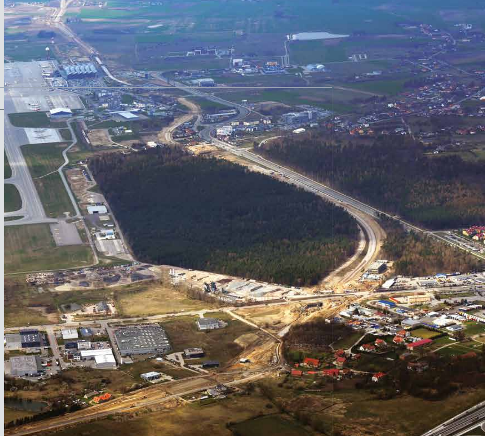
Odcinek budowanej linii PKM pomiędzy Matarnią i lotniskiem widziany z lotu ptaka.
