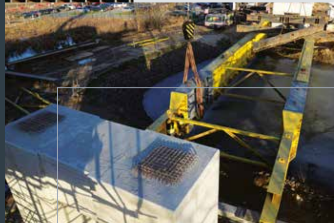
Montaż stalowych dźwigarów pod estakadą WK 36.
