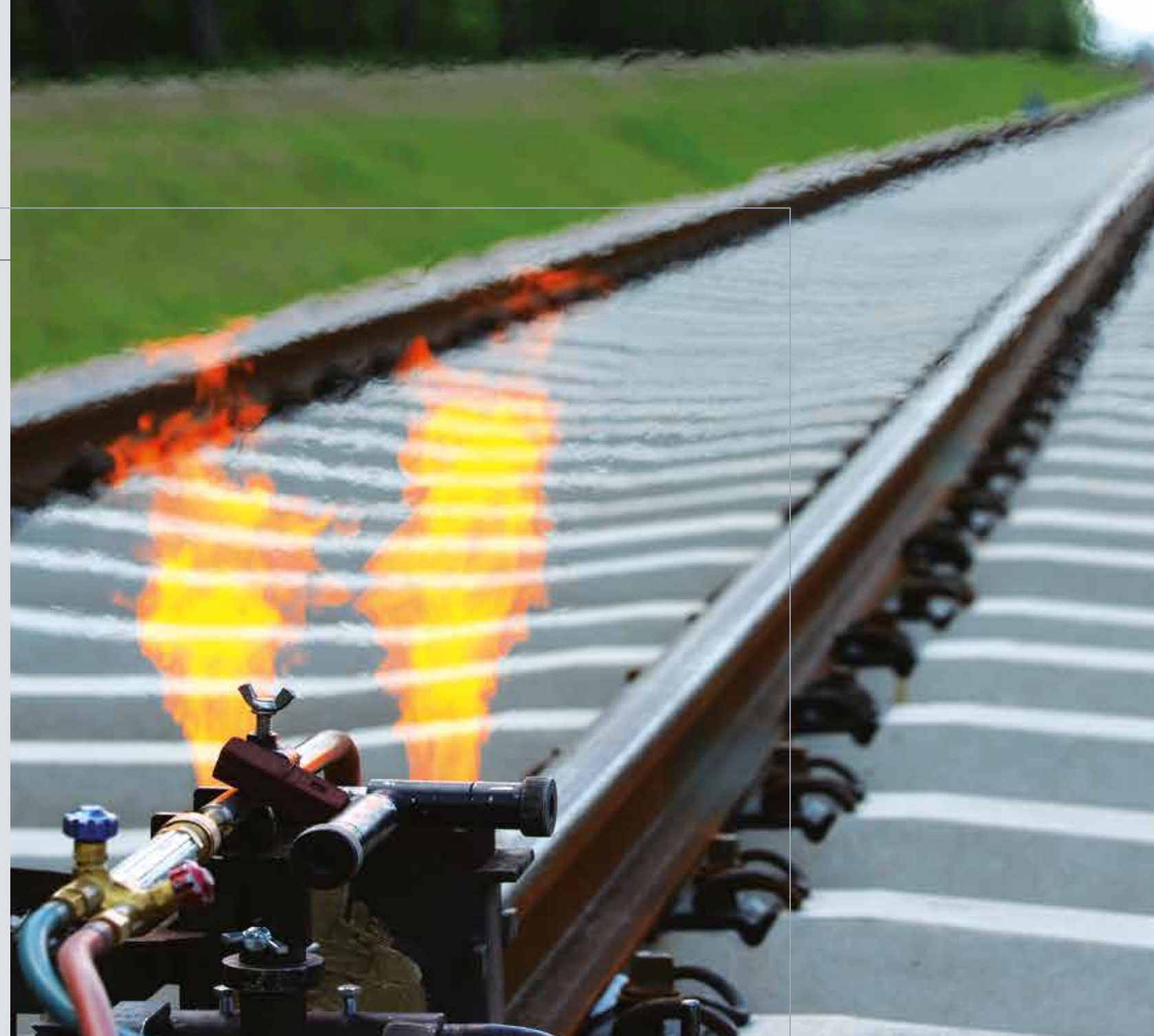
Spawanie szyn na pierwszym gotowym już odcinku torowiska PKM na gdańskiej Matarni.
