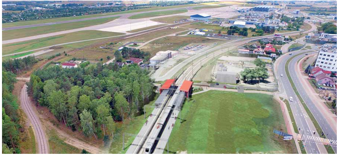
Przy okazji elektryfikacji linii PKM wybudowany zostanie także dodatkowy przystanek Gdańsk Firoga, który będzie służył głównie pracownikom pobliskich firm branży IT.
