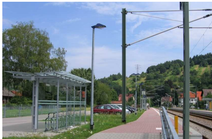
Karlsruhe Light/Heavy Rail Track-Sharing System, Niemcy
